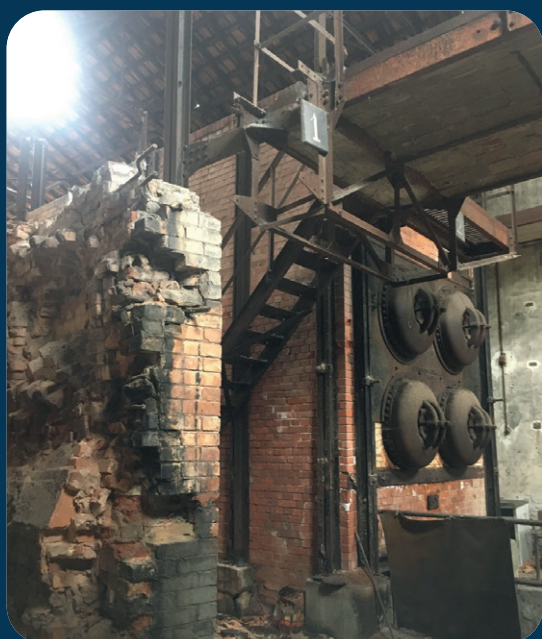
Salle des chaudières © CAUE 34
