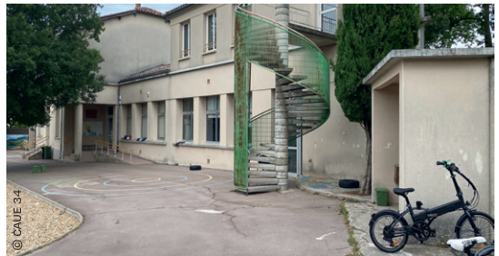
Visite de l'école à rénover en 2022
