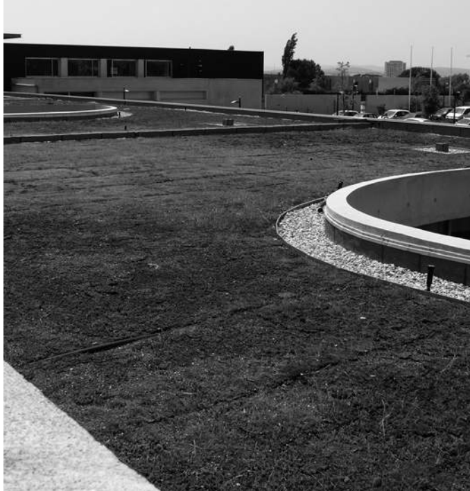
Toiture plantée de sedum
