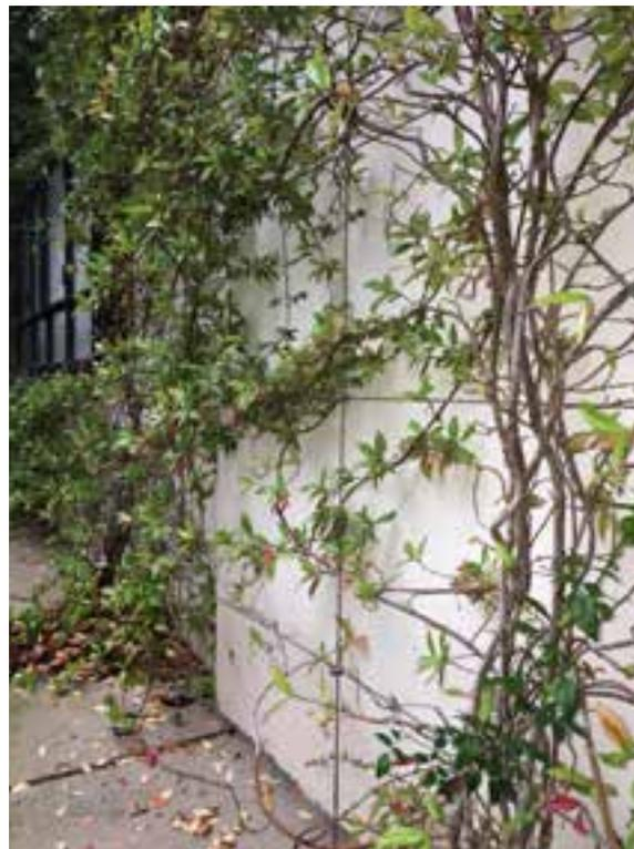
Exemple de structure décalée du mur de 10cm avec câble inox tendu (jasmin de Chine).
