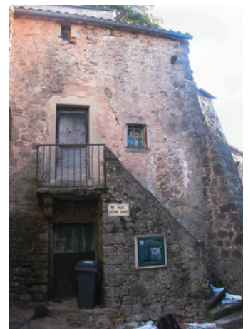
Façade de la maison concernée par le projet au Caylar
