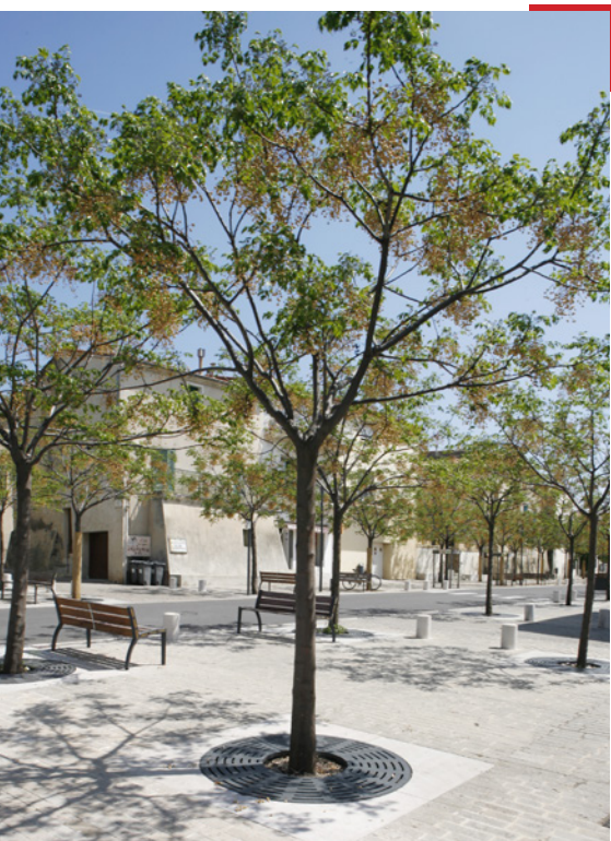
Le Boulevard des Aresquiers requalifié - Maître d'ouvrage : Commune de Vic-la-Gardiole - Maître d'œuvre : Atelier Sites, paysage et urbanisme - Phase 1 : 2005 - Phase 2 : 2008
