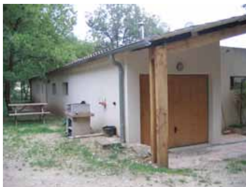
Façade nord et accès garage
