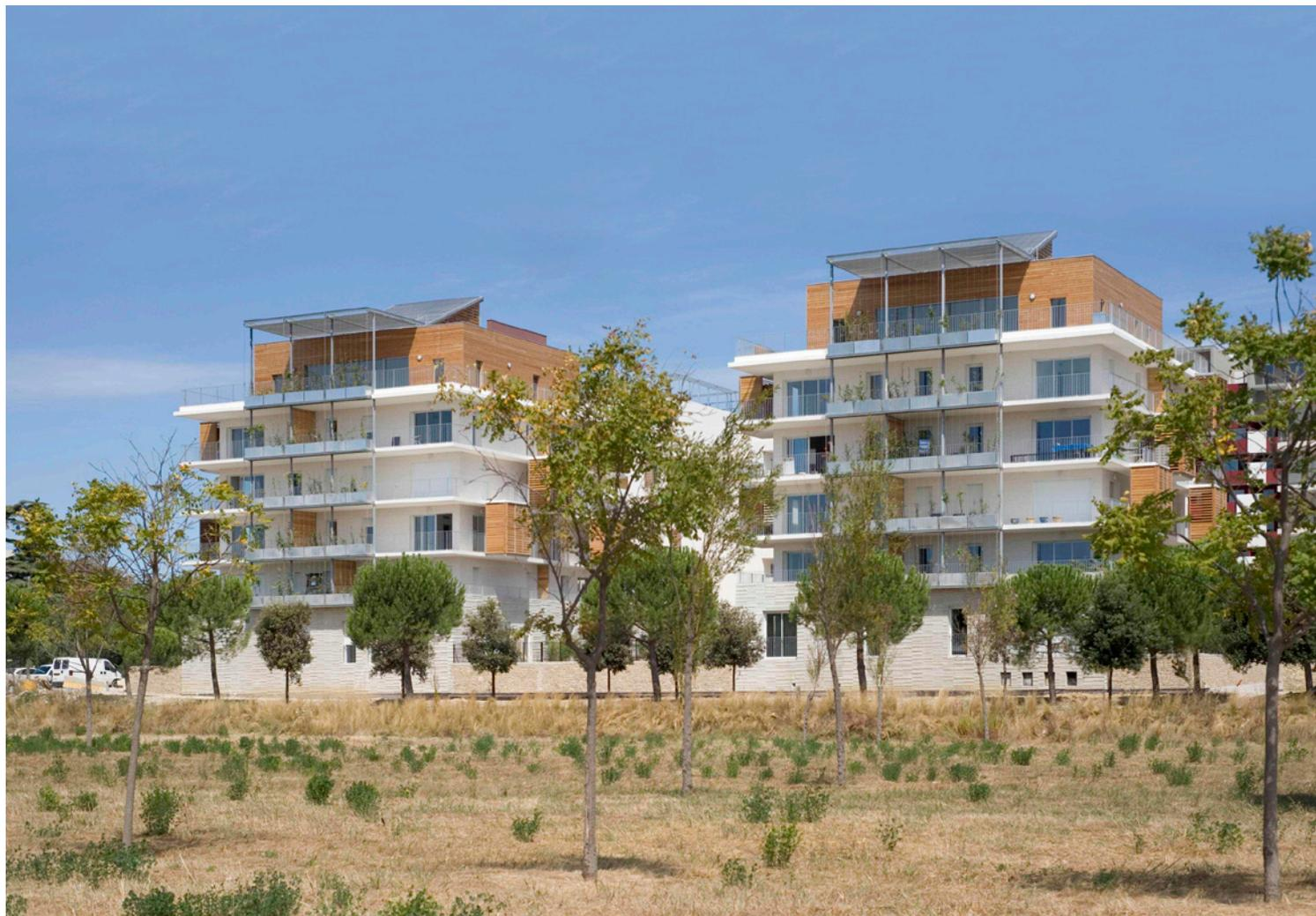
Les balcons filants, d'une largeur allant jusqu'à 2,10 m, assurent une protection solaire aux étages inférieurs. Alors que les «loggias-cabanes» procurent un espace intime, protégé du soleil et du vent.
