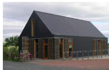
© SCPA Perche - Bougeault Architecte
