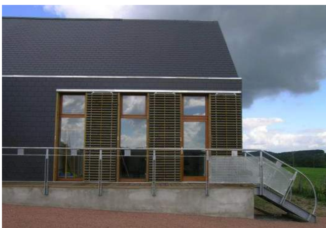
© SCPA Perche - Bougeault Architecte
