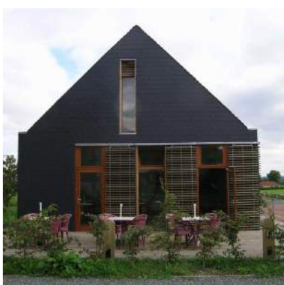
© SCPA Perche - Bougeault Architecte
