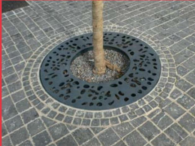
Les pavés de calcaire (bleu belge) sont dessinés et découpés pour s'adapter aux grilles d'entourage des arbres.
